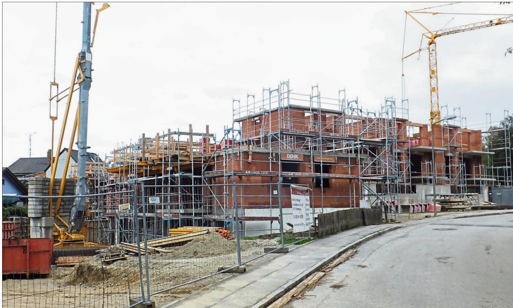
Die Bauarbeiten bei der neuen Wohnanlage an der Karlsbader Straße liegen ziemlich exakt im Zeitplan. Im späteren Herbst sollen das Dach und die Fenster eingebaut werden, damit die Baustelle winterfest wird. (Foto: gs)
